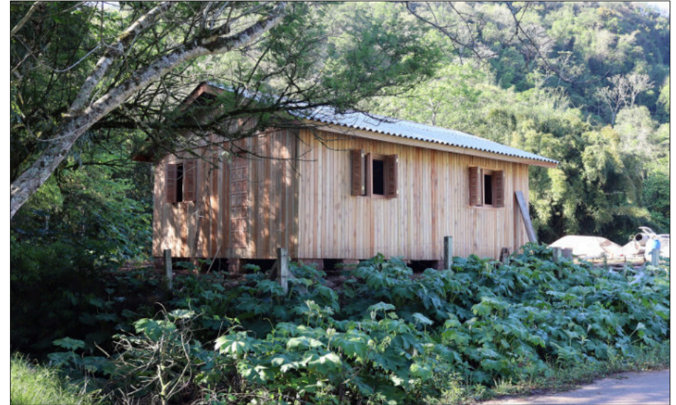
Eins der beiden nach der Flut neu gebauten Mitarbeiterhäuser in Moreira
