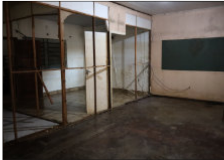
Das Sekretariat ist entkernt und wartet darauf, instandgesetzt zu werden.
