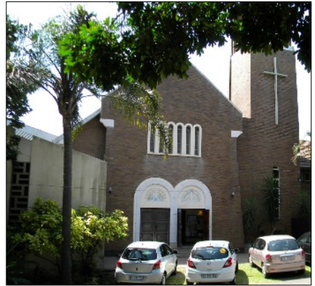
Die Lutherkirche mit angrenzendem Saal
