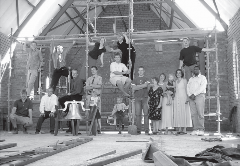
Jugendliche aus Arcadia-Pretoria helfen beim Kirchbau.
