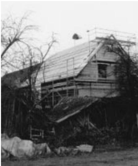
gung mit den Nachbarn über die Grenzziehung erzielt werden. Mitte Oktober konnten die Arbeiten endlich beginnen. Als Erstes waren natürlich Abbrucharbeiten an der Reihe. Übrig geblieben sind der Keller und im Erdgeschoss die Außenwände. Mittlerweile sind die Fundamente saniert, der Keller tiefer gelegt, die Kellerdecke in Teilen erneuert, die Innenwände im Erdgeschoss neu aufgemauert, sodass am 2. Dezember 2000 die Decke gegossen werden konnte.
